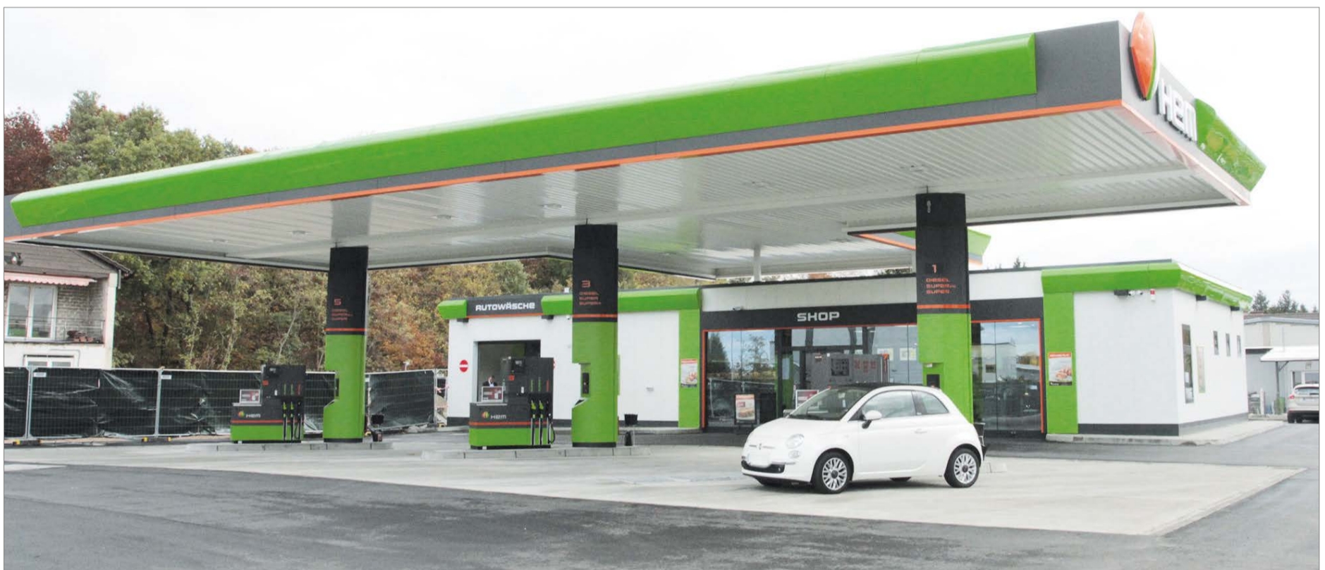
Nach nur vier Monaten Bauzeit konnte damit der elfte Standort in Rheinland-Pfalz in Betrieb genommen werden. 1,5 Millionen Euro wurden investiert.
