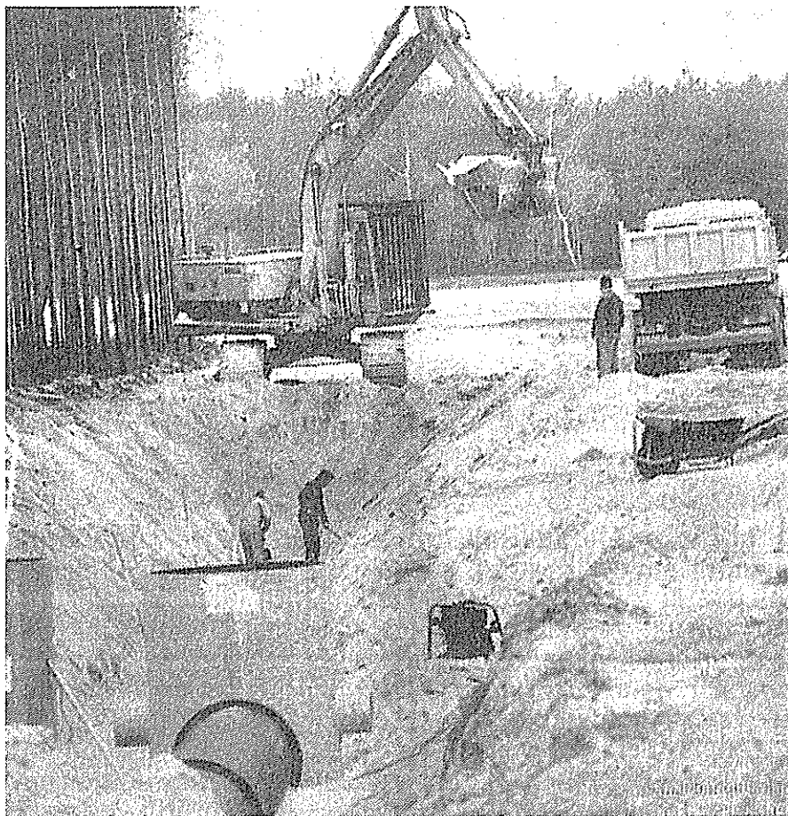
Am Cottbus-Center wird tüchtig gebuddelt. Der Bau eines Regen- und Schmutzwassersammlers wird vorbereitet. (Foto: J. Kaffka)
