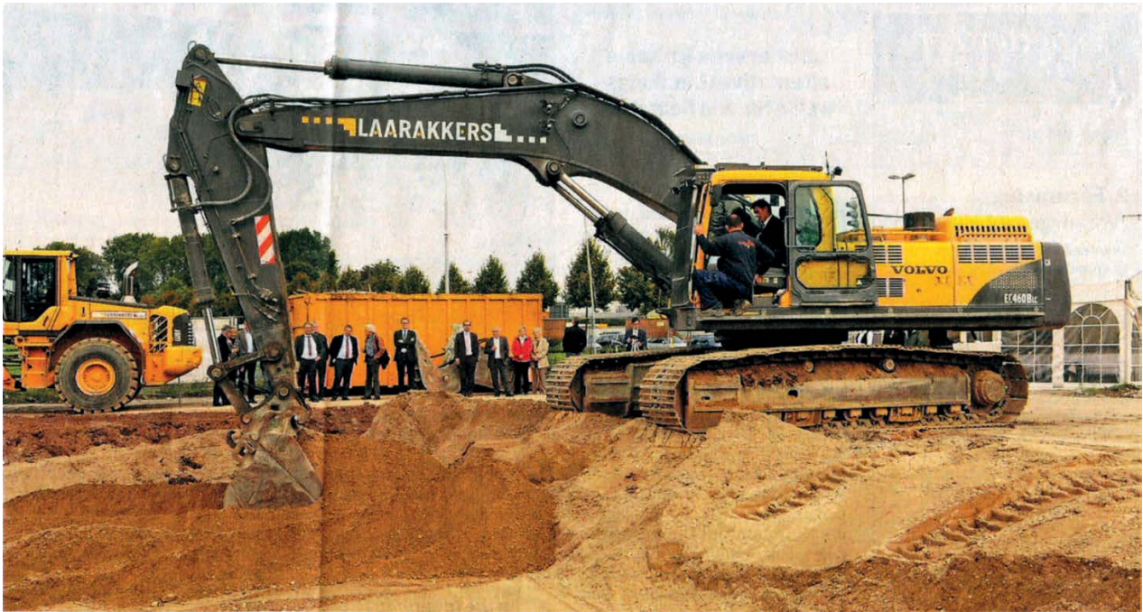
Die UBG-Gruppe eröffnet die Bauarbeiten am ehemaligen Terporten-Gelände mit dem „Baggerbiss“.
