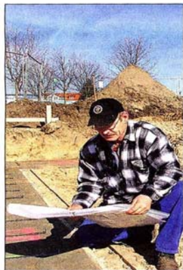
Erwin Wilk, Polier bei der Firma Hoch- und Tiefbau Wittstock, schaut sich den Bauplan an.
